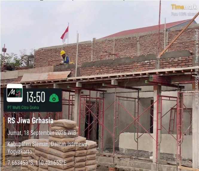
Pemasangan Atap Rumah Satpam dan KM Umum
