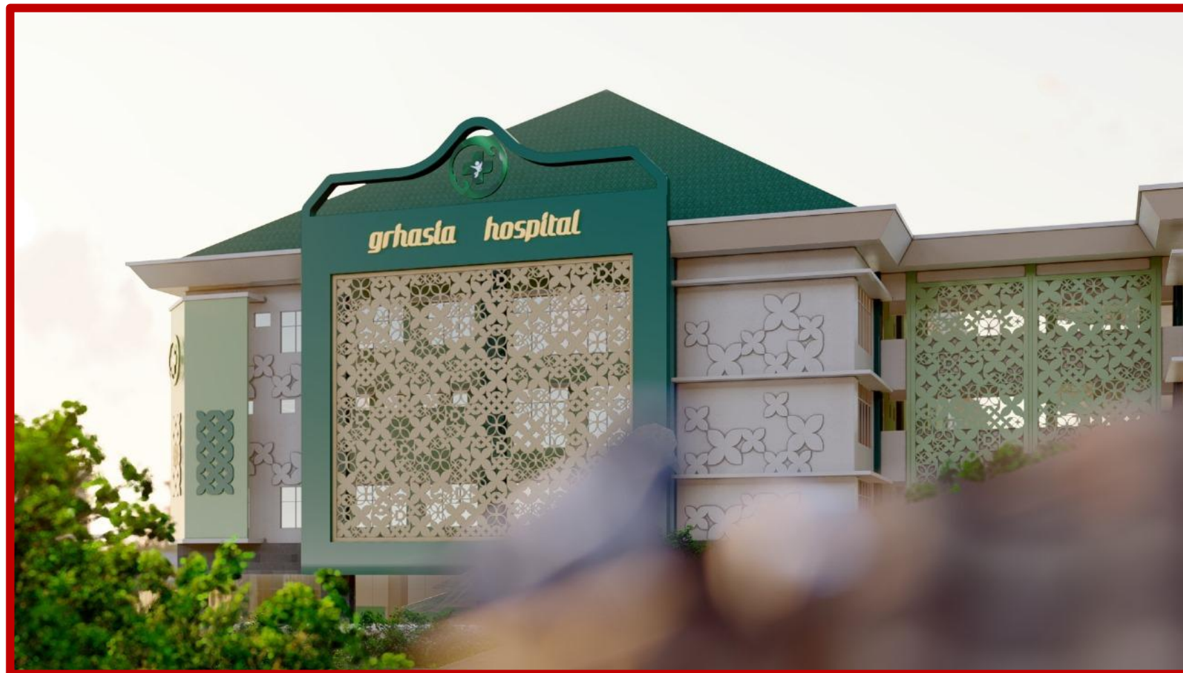
Tampak Selatan Gedung Rawat Jalan Umum RS Grhasia
